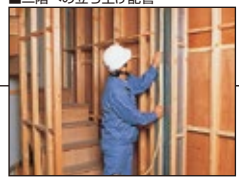
■二階への立ち上げ配管
