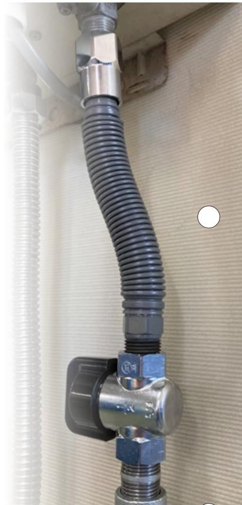
最小曲げ半径以下では取り付けしないで下さい。無理に曲げて取付けると「ガス漏れ」の原因になり危険です。
